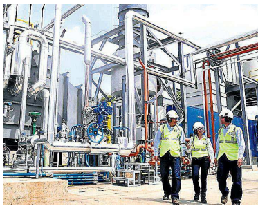
PLANTA DE YARA INTERNACIONAL en Mamonal - antiguas instalaciones de Aboccol. // CORTESÍA.
